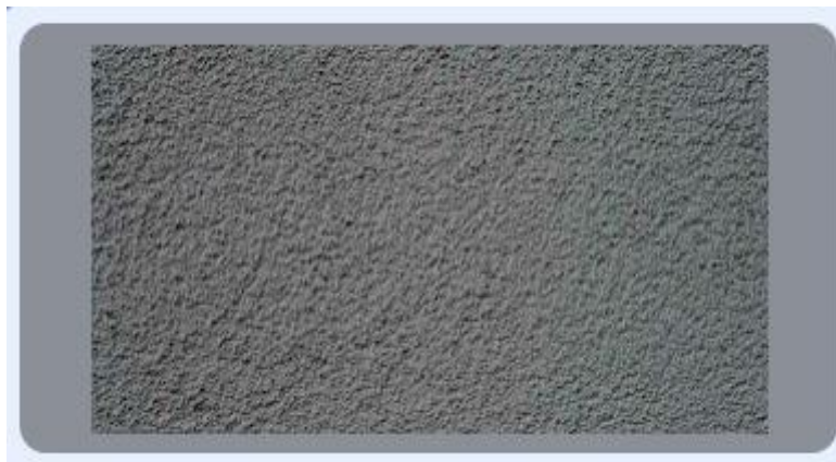
Chapisco encorpado, pronto para receber pintura
